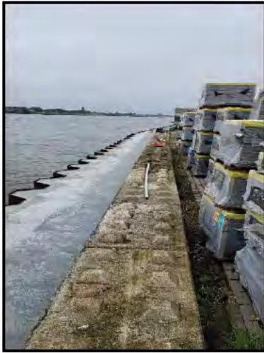
Foto 13: Damwand fase 3 en verharding, 4 september 2024
