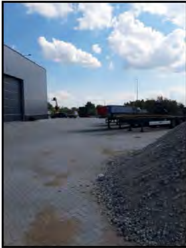
Foto 1: Verharding tpv wijziging en granulaat, 12 december 2019
