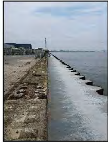
Foto 14: Damwand fase 3 en verharding, 4 september 2024
