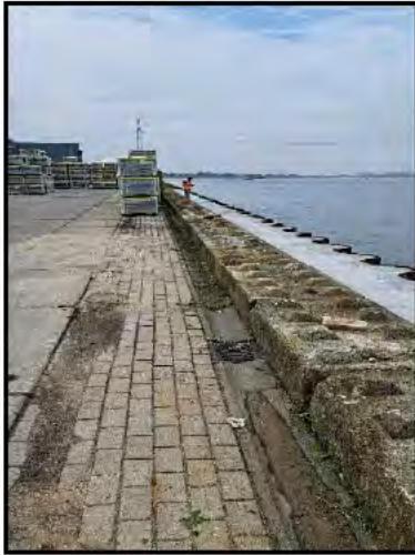
Foto 15: Kolken hemelwaterafvoer, 4 september 2024
