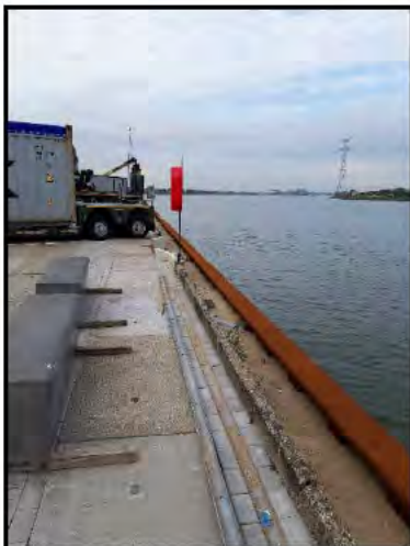
Foto 11: Damwand fase 2, 10 oktober 2022
