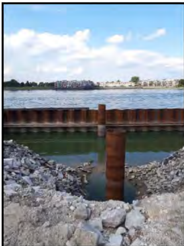
Foto 5: Damwand fase 1, 2 september 2020
