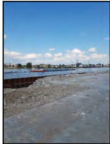
Foto 4: Damwand fase 1, 2 september 2020
