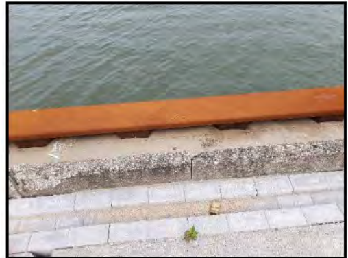
Foto 10: Damwand en verharding, 10 oktober 2022
