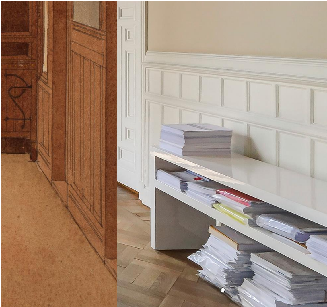
Afb. 8. De lambrisering in ruimte 0.6 lijkt nog het meest op de heel schetsmatig ingetekende lambrisering van afb. 5. Toch is de verhouding van de huidige lambrisering anders dan de verhouding van die op tekening.
