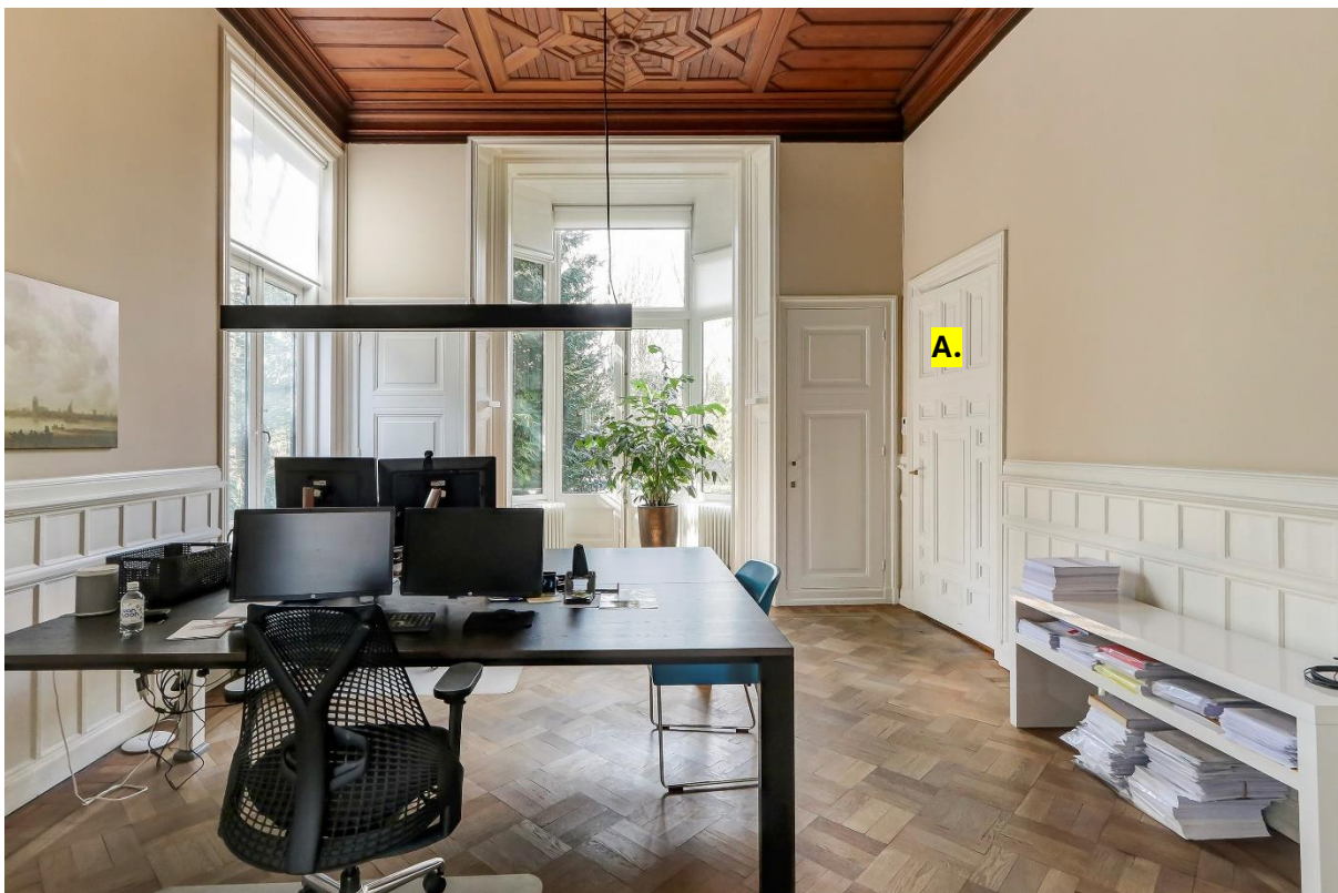
Afb. 7. De lambrisering in 0.6 (woonkamer) is wel hoger en anders van vorm als afb. 6. De deur (A) is mogelijk afkomstig van de afgeschuinde hoek van de kamer die in de jaren 1927 is vervangen voor een nieuwe kamerscheidende wand. In de lambriseringen zijn naden aangetroffen die mogelijk wijzen op het verplaatsen, verschuiven of aanhelen van deze afwerkingen.
