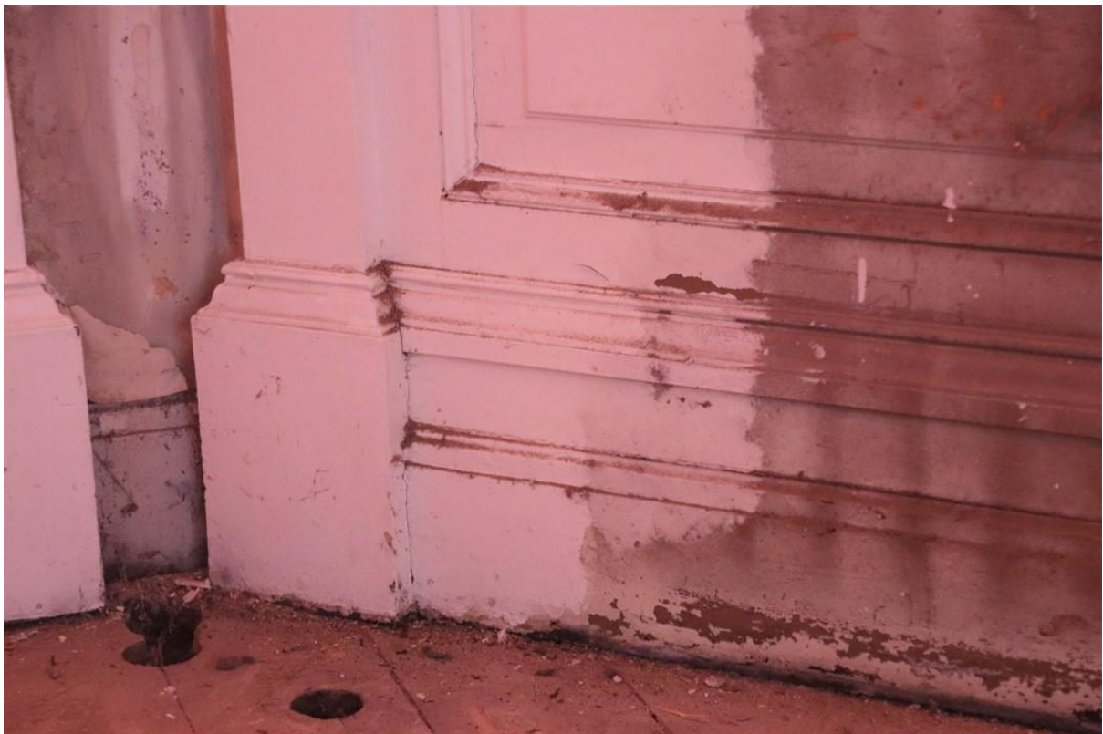
Detailfoto's 1 en 2: na ontmanteling van de interieurafwerking blijken de lage lambriseringen in de salon (ruimte 0.5) sporen te hebben van een wandafwerking die aansluit op de bovenzijde van deze wandbetimmering. Waarschijnlijk zijn deze lambriseringen nog restanten van de oorspronkelijke ontwerpen (N.B. rode kleur op de foto's door bouwzeil).
