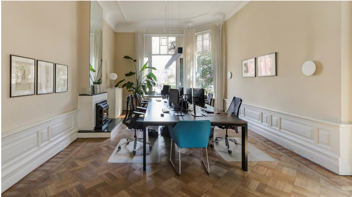
Afb. 6. Lambriseringen in salon (ruimte 0.5) zijn restanten van de oude lambriseringen. De lambrisering op de ontwerptekening (afb. 3) en de foto uit ca 1910 (afb. 4) geven een veel hogere kamerlambrisering weer, waarschijnlijk is alleen de onderzijde van de lambrisering behouden (zie detailfoto's 1 en 2)
