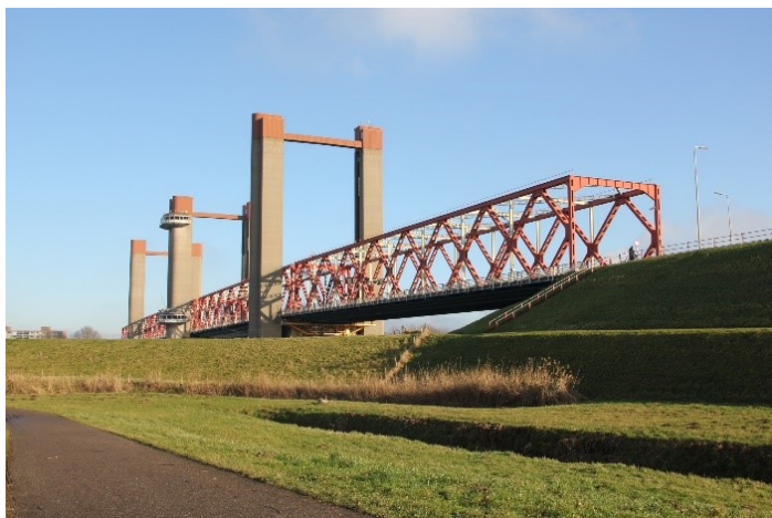
Mogelijke nieuwe bestemming van 4 delen van Keizersveerbrug: De Spijkenisserbrug
