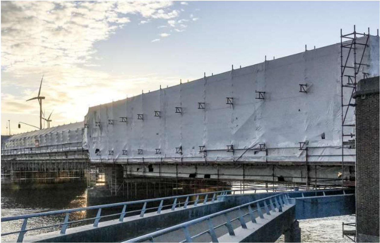
Figuur 4.3: Voorbeeld tentzeil rondom brugconstructie
