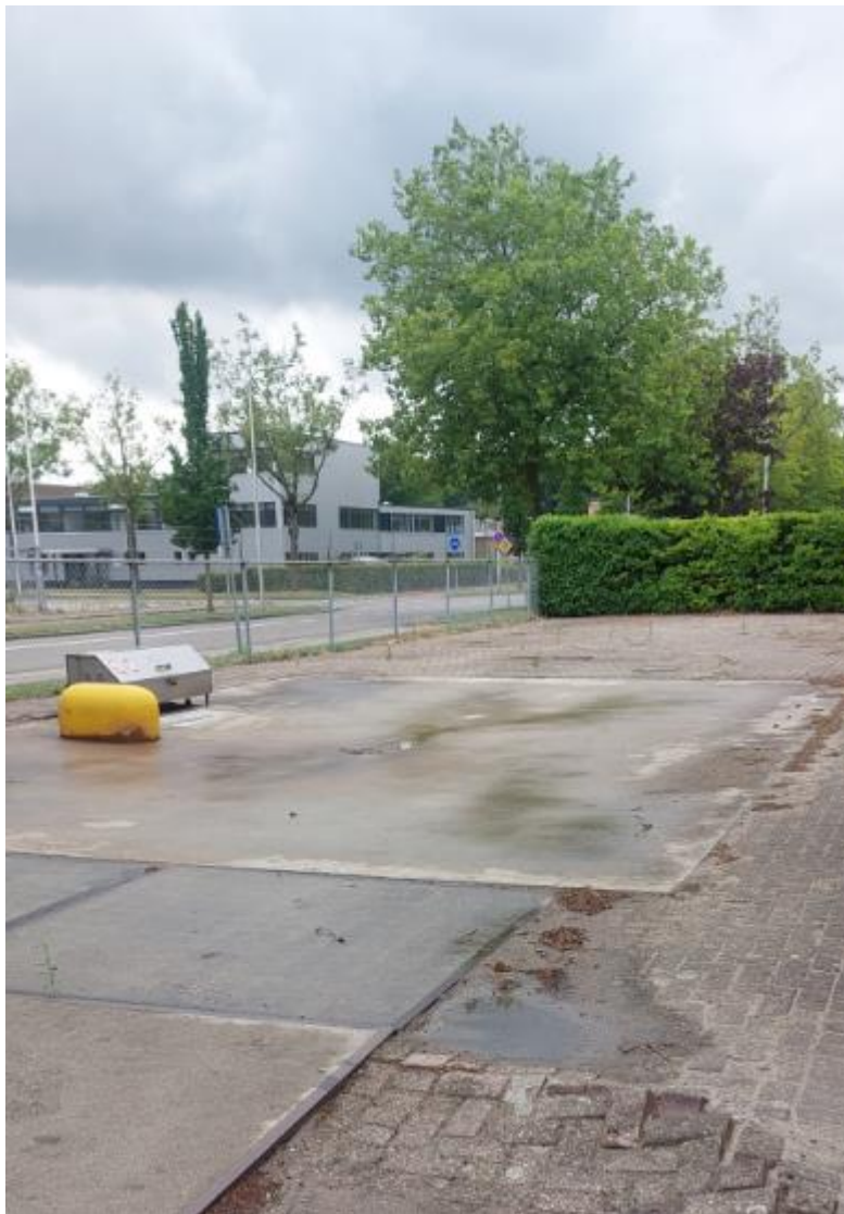
figuur 2: Vloeistofdichte vloer op het buitenterrein.
