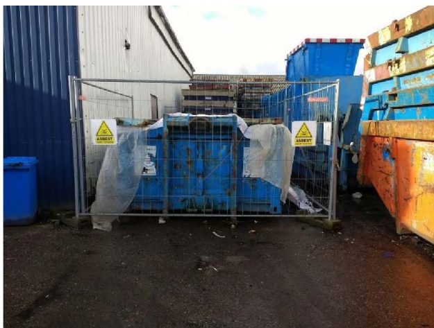
Opslag asbesthoudend materiaal
