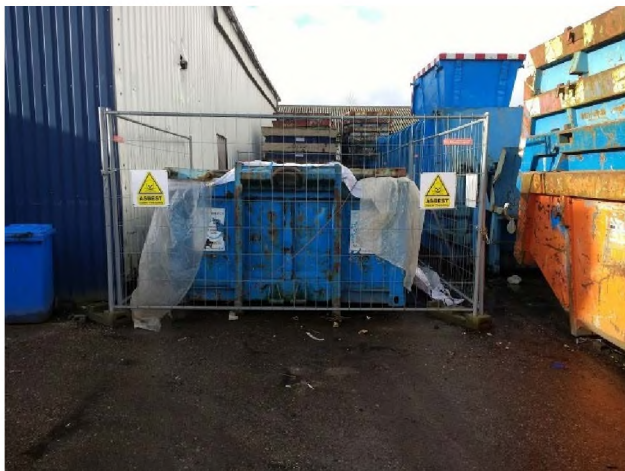
Opslag asbesthoudend materiaal
